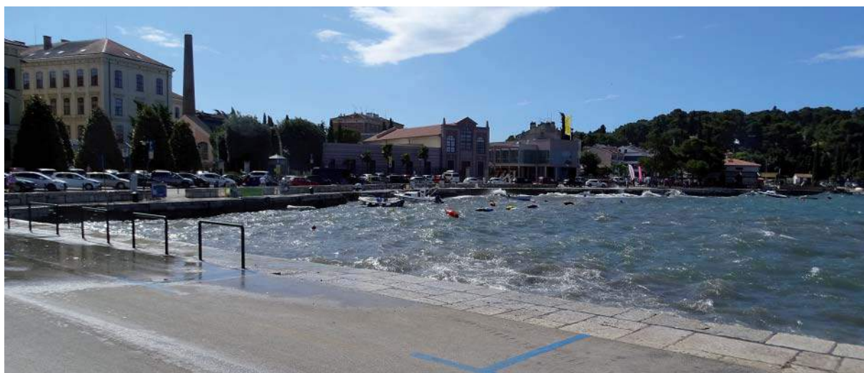
Slika 1: Uvala Val de Laco - područje izgradnje dijela luke oznake LK3
