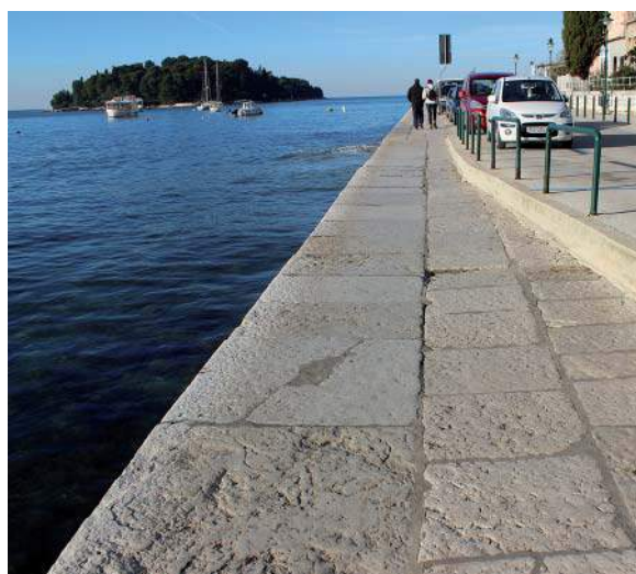
Slika 10: Postojeći kameni obalni zid - suhozid
