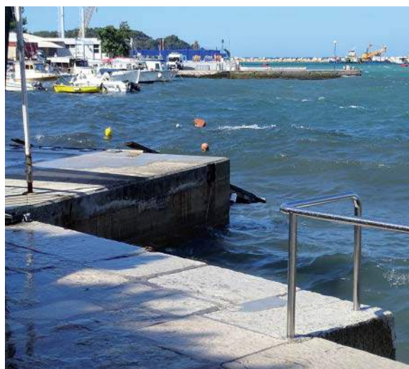
Slika 6: Dio uz jedriličarski klub-područje izgradnje dijela luke oznake LS
