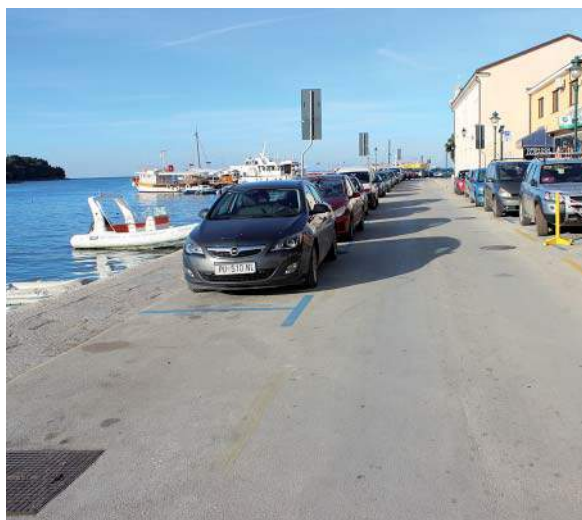
Slika 11: Postojeći kameni obalni zid - suhozid
