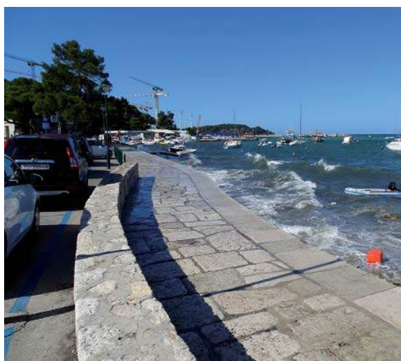
Slika 9: Postojeći kameni obalni zid - suhozid
