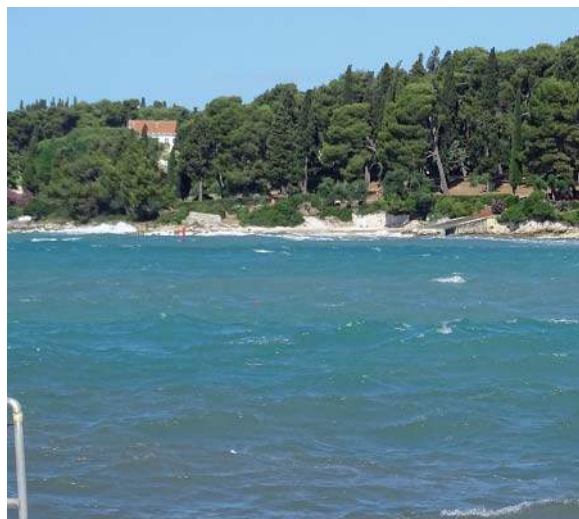
Slika 8: Otok Sv.Katarina-područje izgradnje južnog lukobrana
