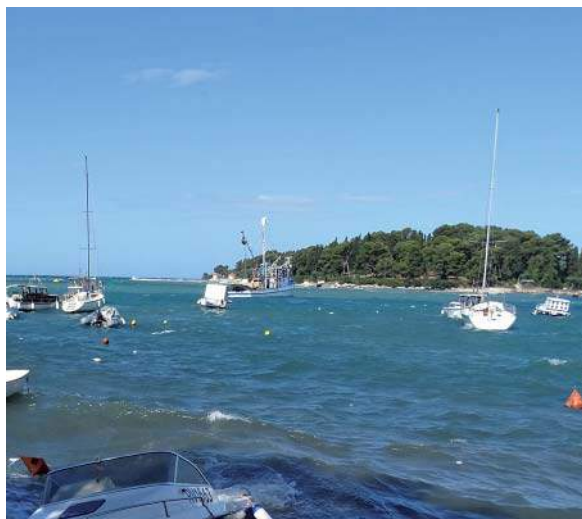
Slika 7: Otok Sv.Katarina-područje izgradnje južnog lukobrana
