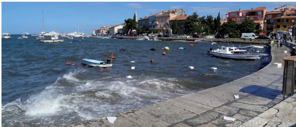
Slika 2: Uvala Val de Laco - područje izgradnje dijela luke oznake LK3
